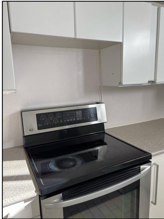
Missing hood fan
